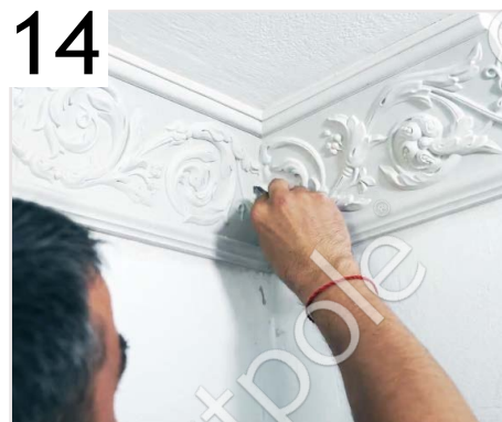
14 Будьте осторожны, чтобы не повредить рисунок изделия!
