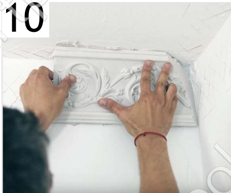
10 Приложите карниз к поверхности и прижмите на 1-2 минуты
