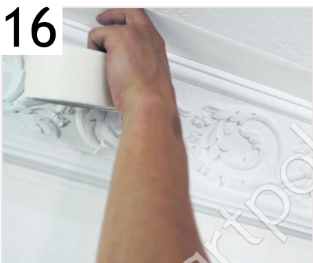
16 Наклейте малярный скотч по периметру карниза на стену и потолок
