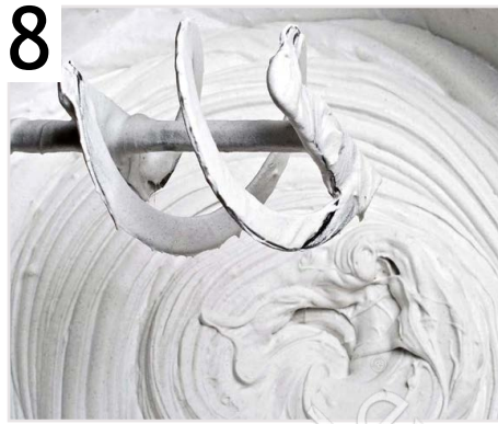
8 Замесите гипсовую шпаклевку Rufas (внимательно ознакомьтесь с инструкцией на упаковке)
