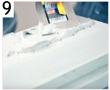
9 Нанесите раствор на тыльную сторону карниза зубчатым шпателем
